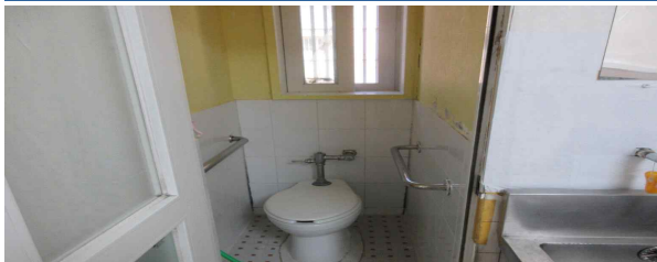
<화장실 안전바 설치>
