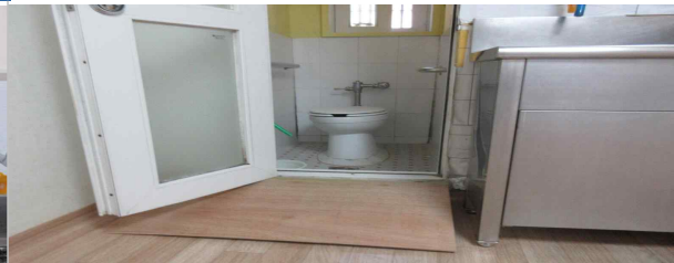
<화장실 입구 경사면 설치>
